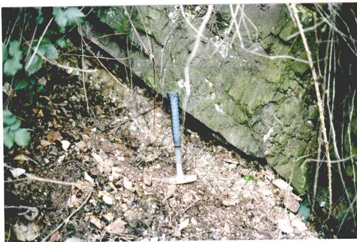
FOTO 1. CAPA DE CAOLIN EN EL TALUD DEL FERROCARRIL DE ENSIDESA - Gijón (1 er tunel) (Veriña) (214)
